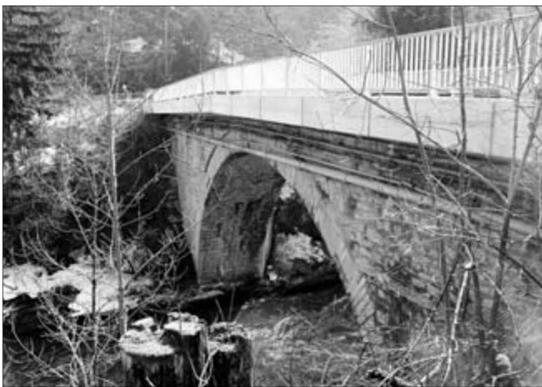
A gauche, la mise en place des 14 éléments préfabriqués de 24 tonnes chacun. A droite, le pont rénové, toujours supporté par l'arche de pierre. JESSICA GENOUD
