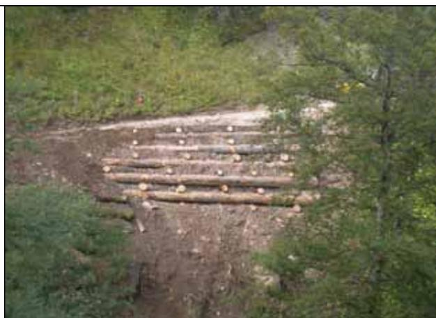
Au printemps 2013, le chemin situé au sud-ouest du chalet s'est affaissé sur plus de la moitié de sa largeur. Cet affaissement a eu lieu à l'endroit où l'enrochement qui le soutient s'est érodé (longueur : environ vingt mètres). Un éboulement s'est également produit au départ du chemin, côté amont.
